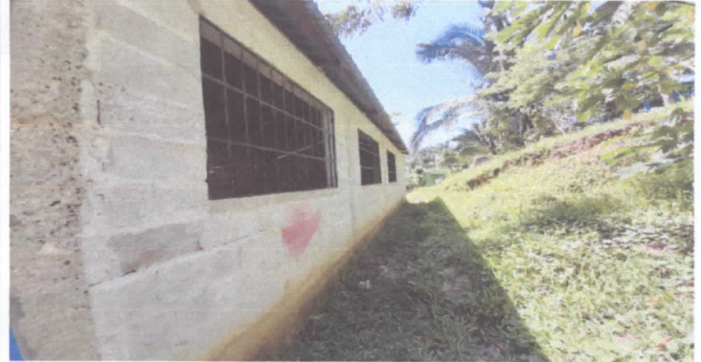
FOTO 4: REPARACIÓN DE REPELLO
