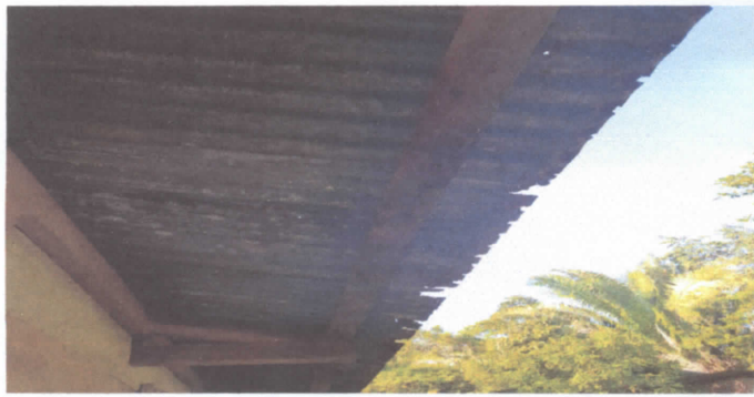
FOTO 3: SUSTITUCIÓN DE LÁMINA
