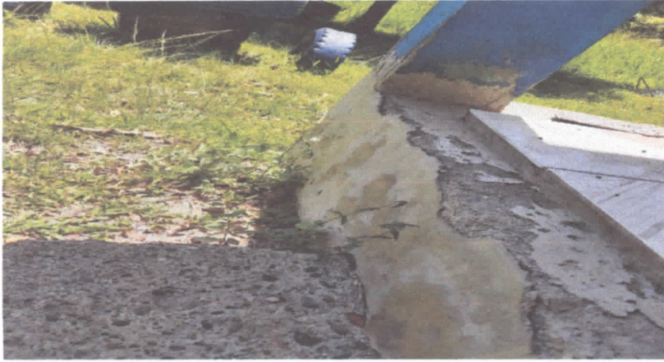
FOTO 1: REPARACIÓN DE PISO CERAMICO
