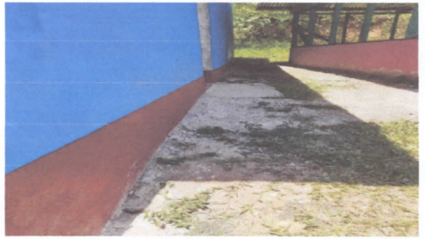
FOTO 2: REPARACIÓN DE PISO DE TORTA DE CONCRETO
