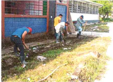
FOTO 1. LIMPIANDO EL AREA DE LA BANQUETA 30/3/24.
