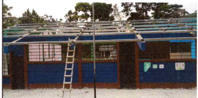
Foto 4: cambio de costaneras 10/5/24
