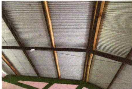
Foto 3. Durante: cambio de costaneras 18/4/24
