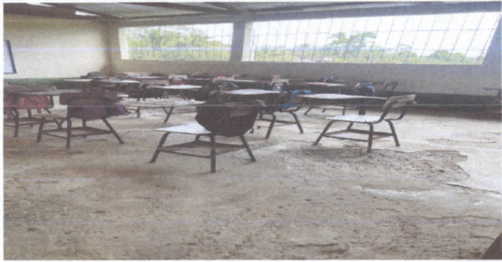
FOTO 1: Sustitución de piso de cemento liquido
