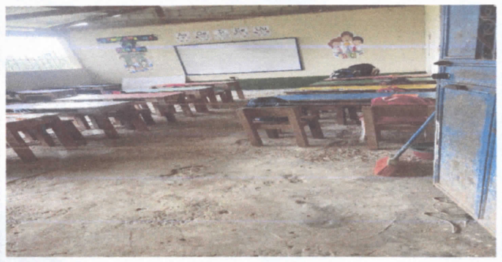
FOTO 2: Sustitución de puerta
