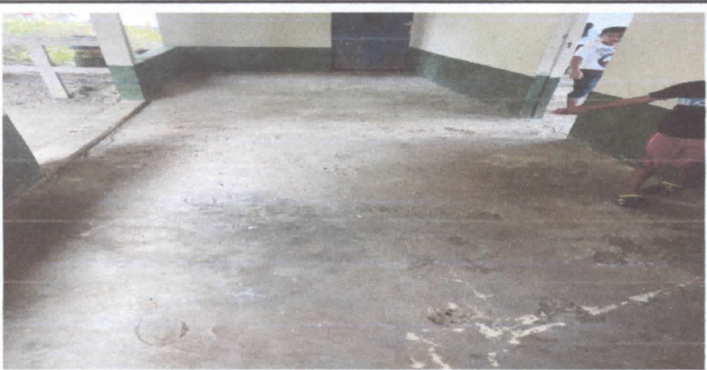
FOTO 3: PINTURA EN MUROS INTERIORES Y EXTERIORES
