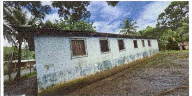
Foto 10: SUMINISTRO Y COLOCACION DE LAMINA
