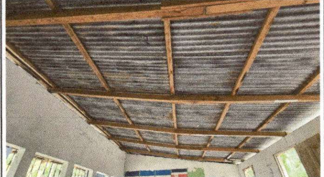
Foto 8: MODULO "A" SUMINISTRO E INSTALACION DE ESTRUCTURA METALICA EN AULA
