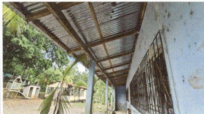
Foto 9: SUMINISTRO Y COLOCACION DE ESTRUCTURA METALICA
