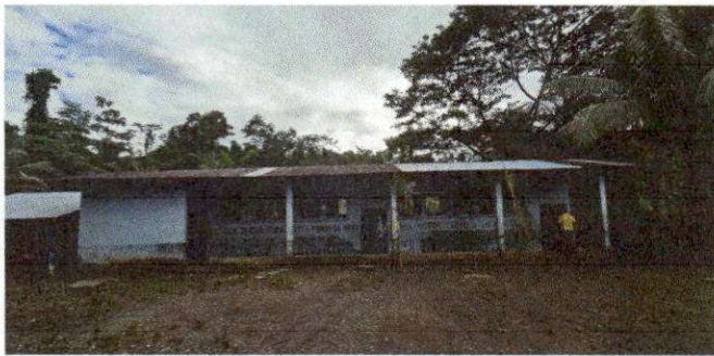
Foto1: . MODULO "A" REMOZAMIENTO DE TECHO
