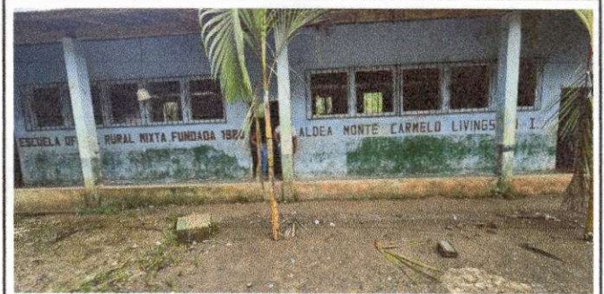
Foto 4: MODULO "A" REMOZAMIENTO DE TECHO
