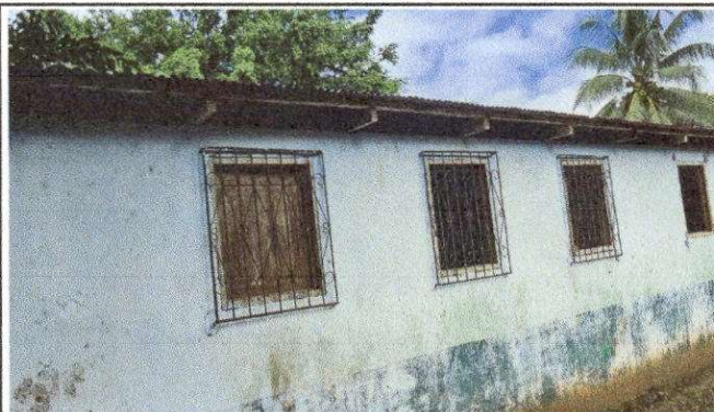
Foto 11:SUMINISTRO E INSTALACION DE ESTRUCTURA METALICA
