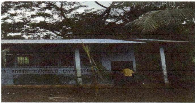
Foto 3: MODULO "A" REMOZAMIENTO DE TECHO SUMINISTRO E INSTALACION DE LAMINA
