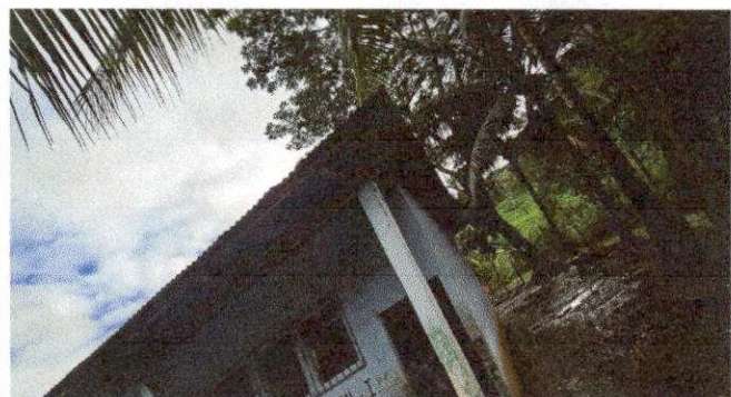
Foto 5: REMOZAMIENTO DE TECHO SUMINISTRO Y COLOCACION DE ESTRUCTURA METALICA.
