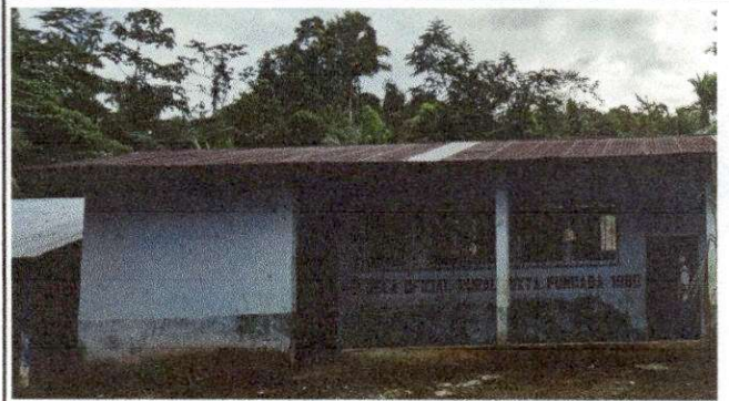
Foto 2: MODULO "A" REMOZAMIENTO DE TECHO SUMINISTRO E INSTALACION DE LAMINA
