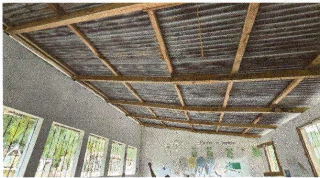
Foto7: . MODULO "A" SUMINISTRO E INSTALACION DE LAMINA
