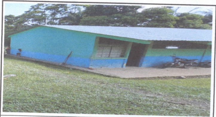
FOTO 4: PINTURA EN MUROS INTERIORES Y EXTERIORES
