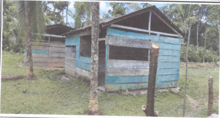
FOTO 1: SUSTITUCIÓN DE LAMINA Y SUSTITUCIÓN DE PISO DE CONCRETO
