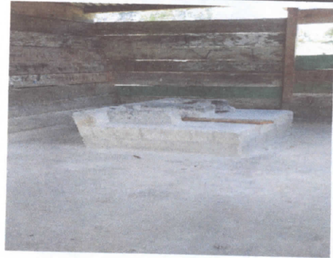
FOTO 2: SUSTITUCIÓN DE PLANCHA DE METAL DE 3 HORNILLAS
