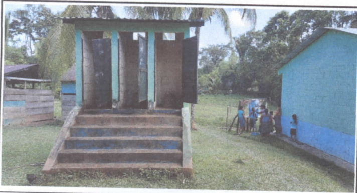
FOTO 3: SUSTITUCIÓN DE PUERTAS, SUSTITUCIÓN DE INODOROS, SUSTITUCIÓN DE LÁMINA, SUSTITUCIÓN Y CAJA DE REGISTRO.
