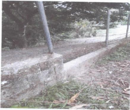
15.2 Reparación de muro perimetral de block con tubo hg y malla galvanizada, soleras intermedias y columnas.
