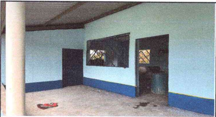
FOTO 3: Mantenimiento a estructura (lijado, sepillado, sujeciones, aplicacion de pintura)de puertas y Sustitución de Puertas en Servicios Sanitarios.
