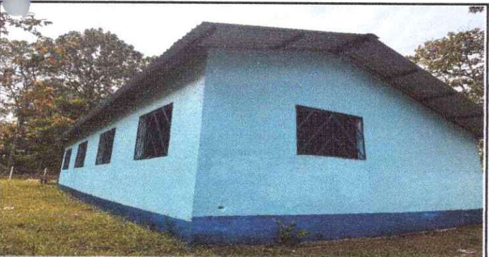
Foto 5: Pintura en muros exteriores e interiores
