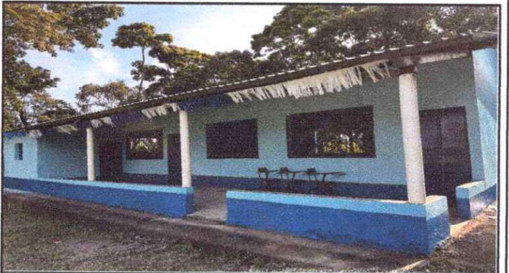
Foto 4: Mantenimiento a balcones de metal
