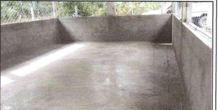
FOTO 6: Sustitución de torta de concreto
