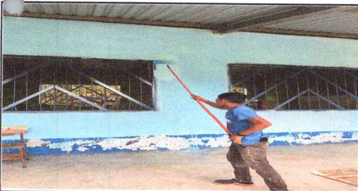
Foto 5: Pintura en muros exteriores e interiores
