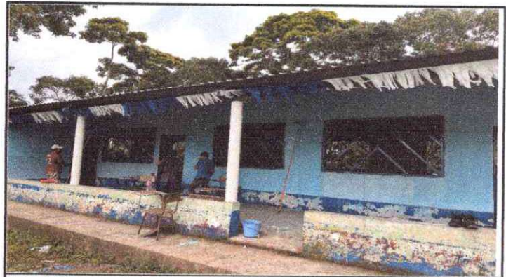
Foto 4: Mantenimiento a balcones de metal
