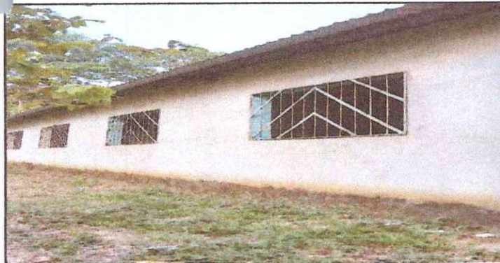
Foto 5: Pintura en muros exteriores e interiores
