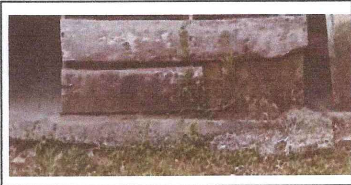
FOTO 6: Sustitución de torta de concreto
