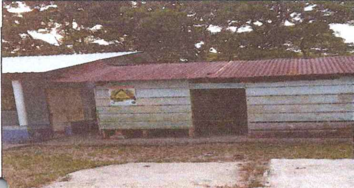
FOTO 1: Sustitucion de lámina, por lámina troquelada Aluzinc calibre 26
