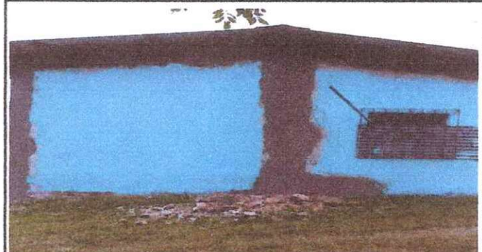
FOTO 2: Sustitución de Columnas y Vigas de Concreto
