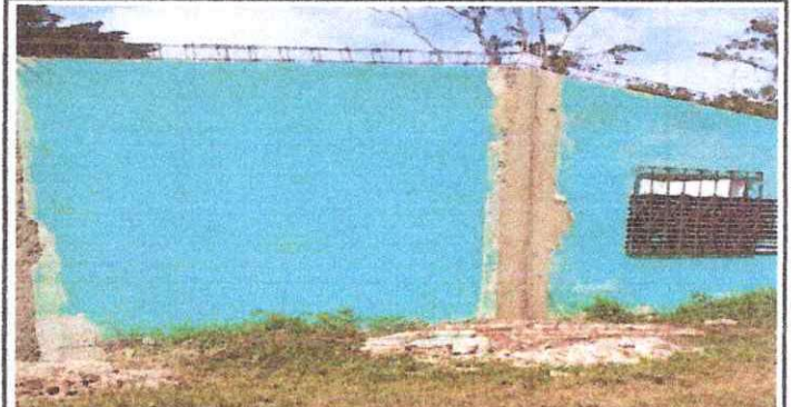
FOTO 2: Sustrucción de Columnas y Vigas de Concreto
