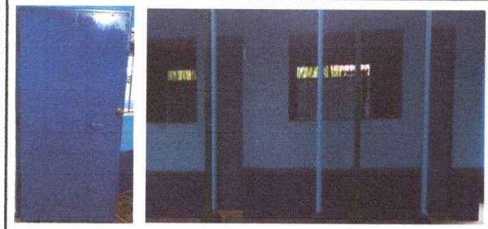
Foto 1: Finalización de la sustitución de puertas de madera por puertas de metal
