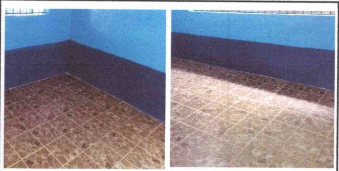
Foto 2: Finalización de la sustitución de piso cerámico
