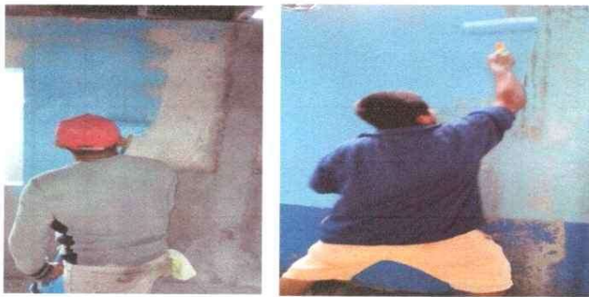
Foto 3: Ejecución de la pintura en muros exteriores e interiores
