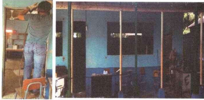
Foto 1: Ejecución de la sustitución de puertas de madera por puertas de metal
