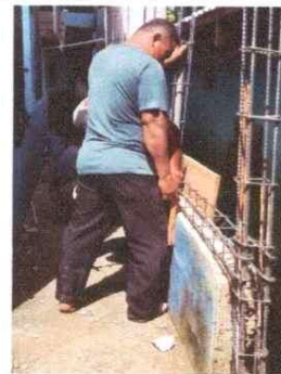
Foto 4: Ejecución de la reparación de muro perimetral de block
