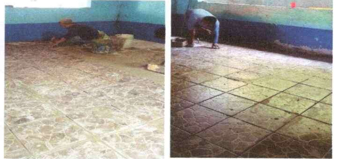
Foto 2: Ejecución de la sustitución de piso cerámico
