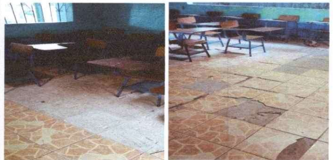
Foto 2: Sustitución de piso cerámico
