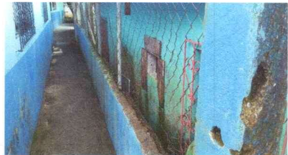
Foto 4: Reparacion de muro perimetral de block
