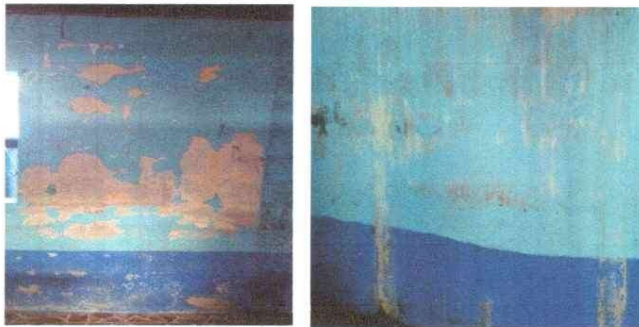
Foto 3: Pintura en muros exteriores e interiores
