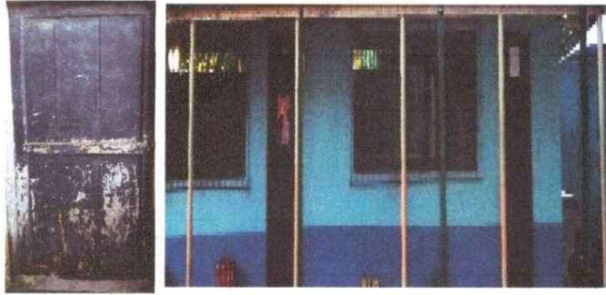
Foto 1: Sustitución de puertas de madera por puertas de metal
