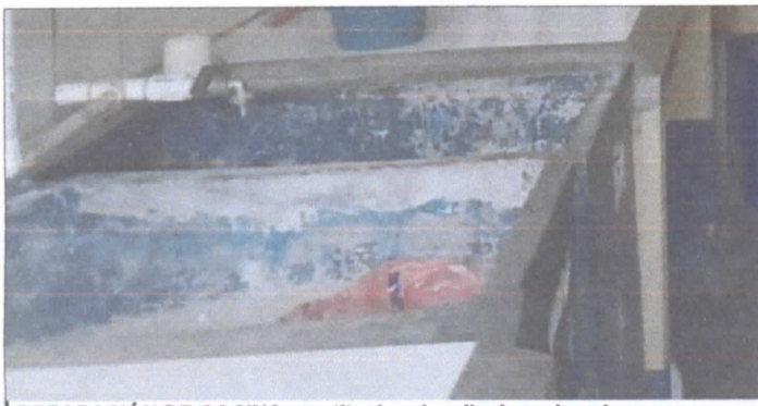
REPARACIÓN DE COCINA: sustitucion de pila de un lavadero
