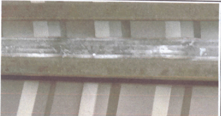
sustitución de costaneras EODP anexa a EORM
