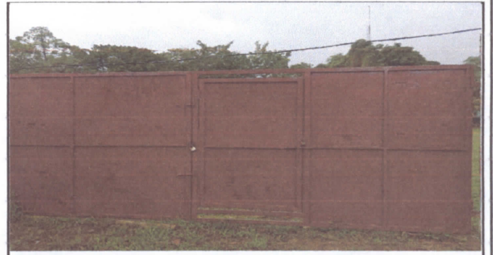
MANTENIMIENTO DE PORTON: Y COLOCACIÓN DE GALERA PROTECTORA EORM
