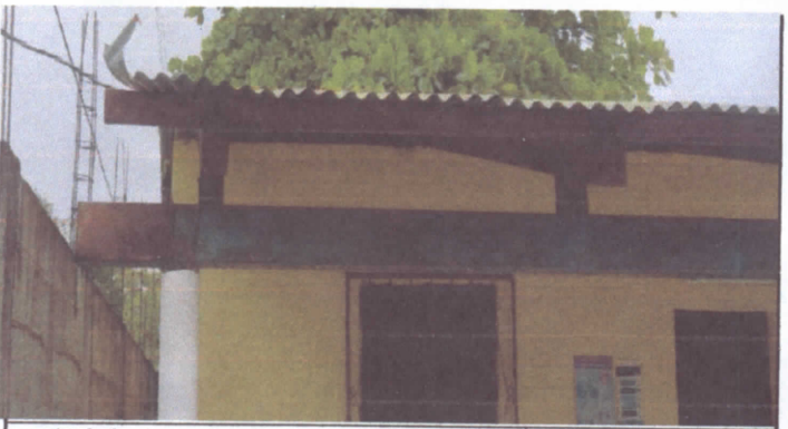
mantenimiento a estructura soporte de metal EORM
