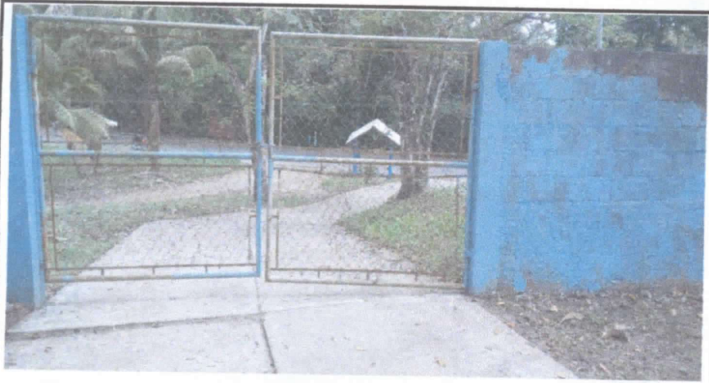
FOTO 3: Fabricación e instalación de Portón de metal de ingreso
