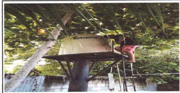
FOTO 6: Sustrucción de depósito de agua 1100 lt
