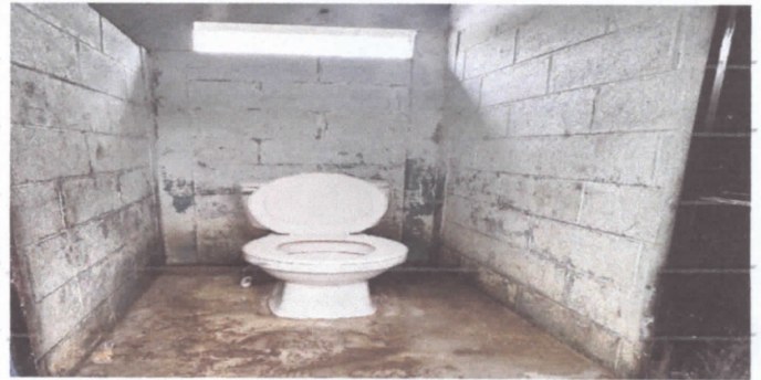
Sustitución de accesorios inodoro (contra llave, tubo de abasto y tanque)
