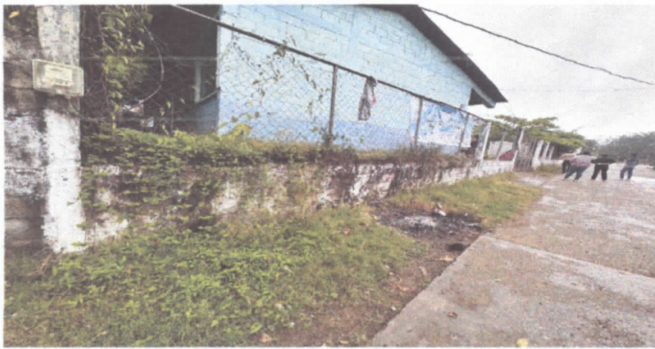
Reparación de muro perimetral de block con tubo hg y malla galvanizada, soleras intermedias y columnas.
