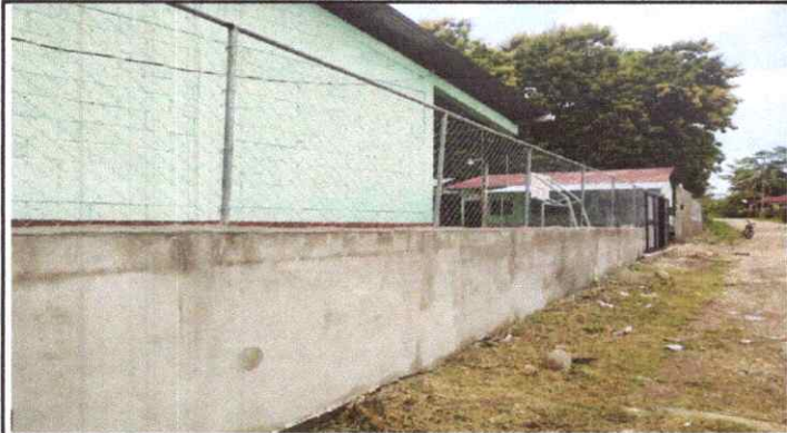
foto 1: sustitucion de muro perimetral de muro y block a block.
