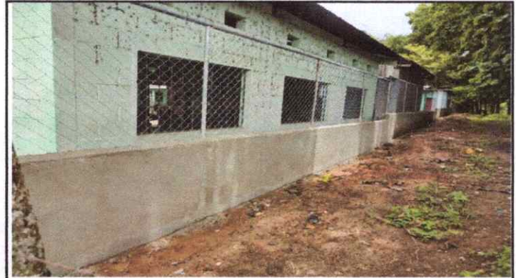
foto 2: sustitucion de muro perimetral de muro y block a block.
