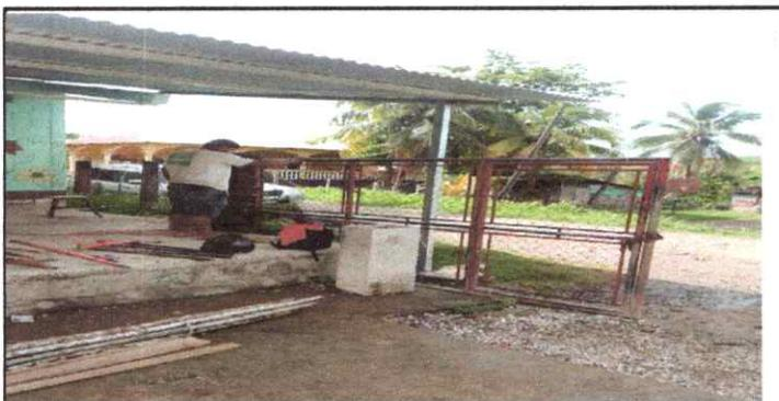
foto 3: sustitucion de porton metálico y malla a porton de lamina y metal.
