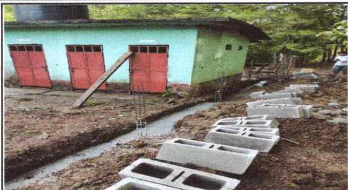
Foto: Sustitucion de muro perimetral de muro y block a block.
