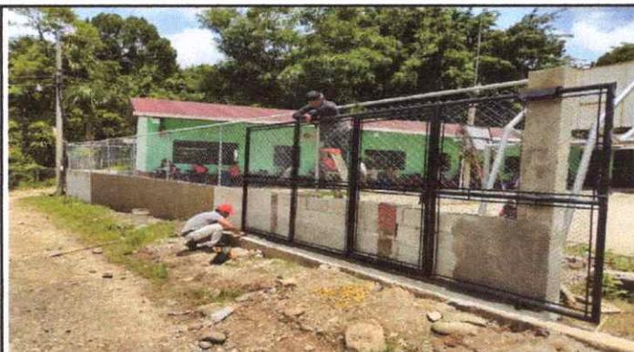
foto 4: sustitucion de porton metálico y malla a portón de lamina de metal.
