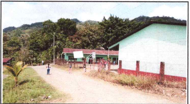
Foto 2: Sustrucción de Muro Perimetral de Muro y Block a Block.
