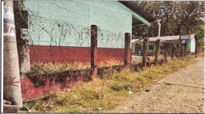
Foto 1: Sustrucción de Muro Perimetral de Muro y Block a Block.
