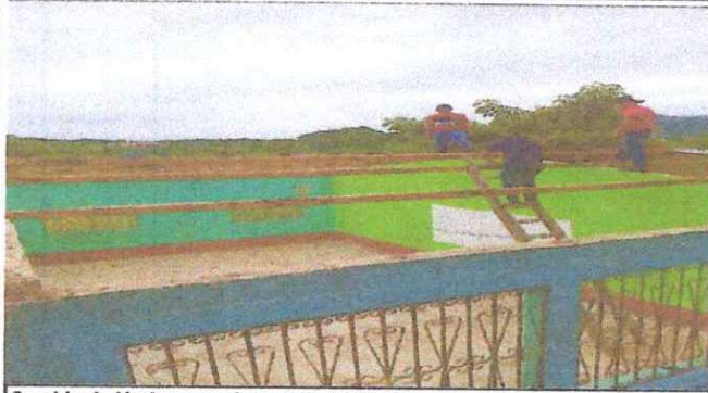
Cambio de lámina y madera en mal estado.
