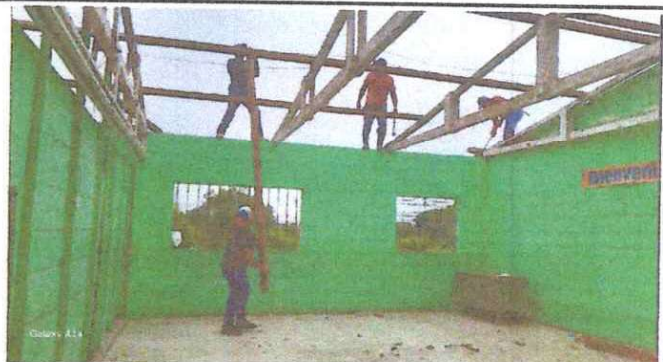
Realizando trabajos de cambio de madera por estructura de metal.
