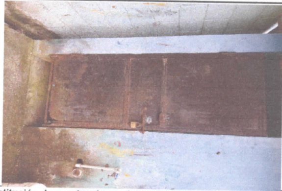
Sustitución de puertas de servicios sanitarios 1,2,3,4
