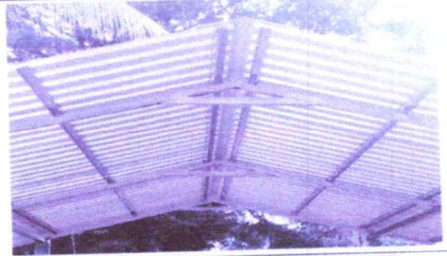
MANTENIMIENTO A ESTRUCTURA DE SOPORTE DE METAL DEL ESCENARIO
