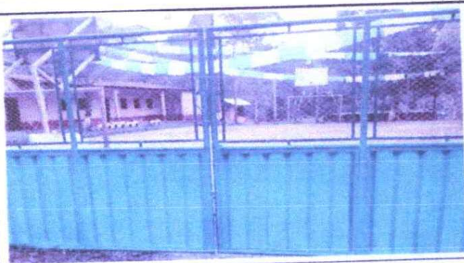
MANTENIMIENTO A PORTONES DE METAL
