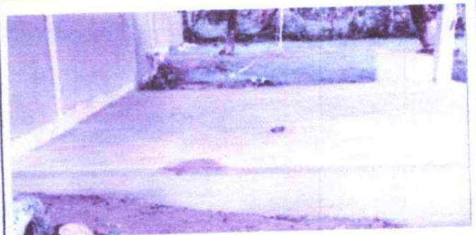
SUSTITUCIÓN DE PISO DE TORTA DE CONCRETO DEL ESCENARIO
