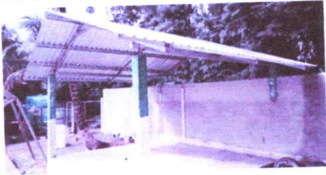
SUSTITUCIÓN DE LÁMINA, POR LÁMINA TROQUELADA ALUZINC CALIBRE 26 DEL ESCENARIO
