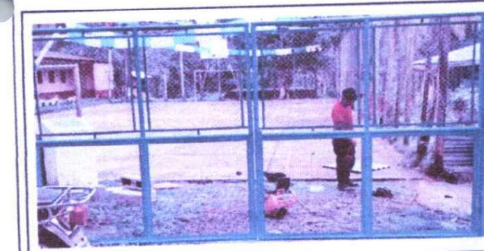
MANTENIMIENTO A PORTONES DE METAL
