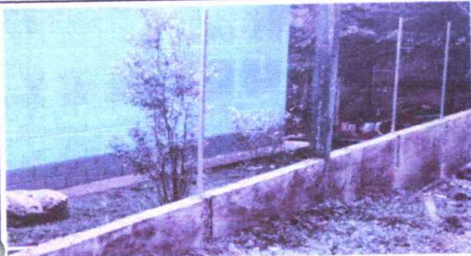
REPARACIÓN DE TUBO HG Y MALLA GALVANIZADA
