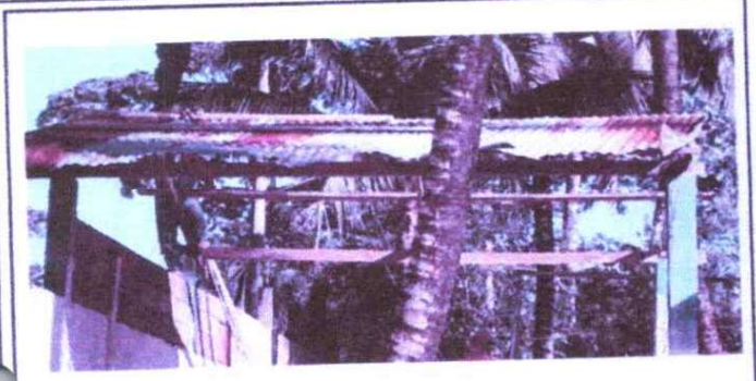
SUSTITUCIÓN DE LÁMINA, POR LÁMINA TROQUELADA ALUZINC CALIBRE 26 DEL ESCENARIO
