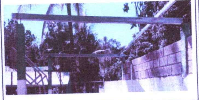
MANTENIMIENTO A ESTRUCTURA DE SOPORTE DE METAL DEL ESCENARIO
