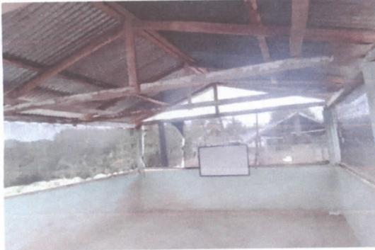
FOTO 1: SUSTITUCIÓN DE LÁMINA Y ESTRUCTURA DE MADERA A METALICA
