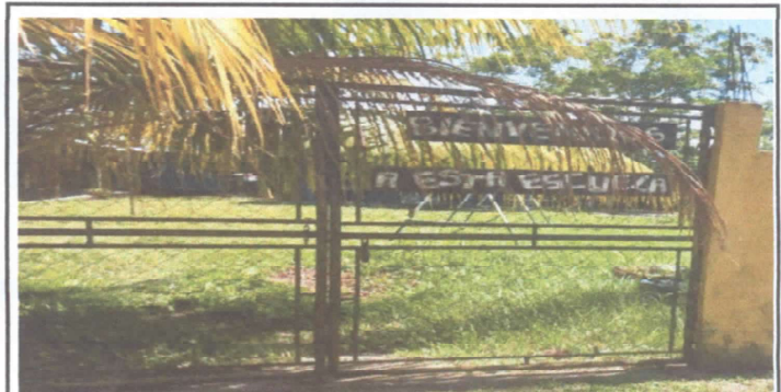
Foto 6. Mantenimiento a portones de metal
