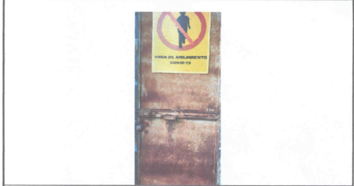
Foto 4. Sustitución de chapa
