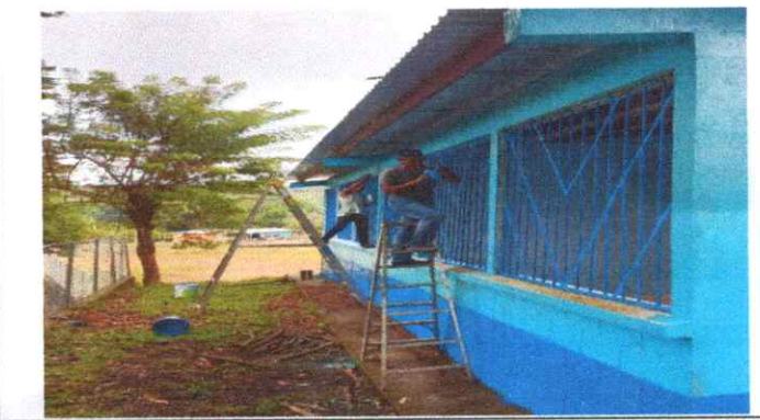
MANTENIMIENTO A BALCONES DE METAL
