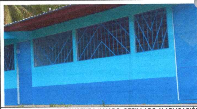
MANTENIMIENTO A ESTRUCTURA (LIJADO, CEPILLADO, Y APLICACIÓN DE PINTURA)
