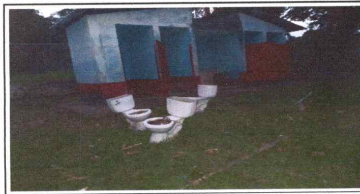
SUSTITUCION DE INODORO (CONTRA LLAVE, TUBO DE ABASTO Y TANQUE)
