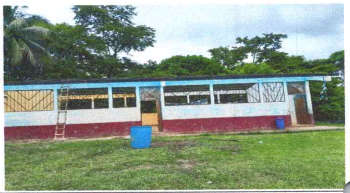
SUSTITUCION DE LAMINA, TROQUELADA ALUCING K26
