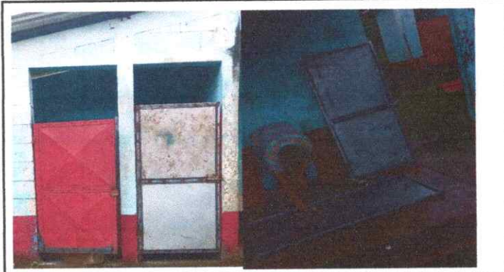
SUSTITUCION DE PUERTAS EN SERVICIOS SANITARIOS
