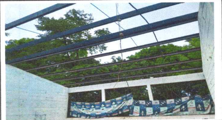
MANTENIMIENTO DE ESTRUCTURA DE SOPORTE DE METAL
