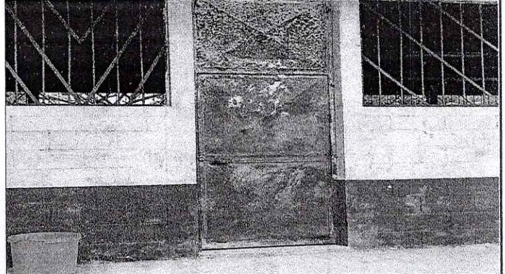
Mantenimiento a estructura, lijado, Cambio de Tubo sujeciones, aplicación de pintura y cepillados
