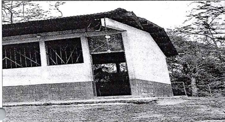
Sustitución de láminas troqueladas (alucinc calibre 26)
