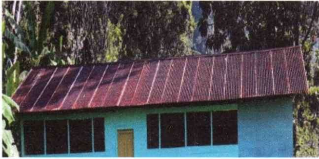
Foto1: Sustitución de lámina, por lamina troquelada aluzinc calibre 26
