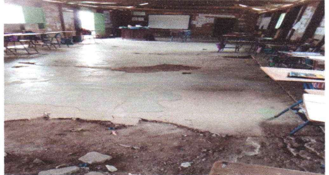
2 Sustitución de piso de torta de concreto
