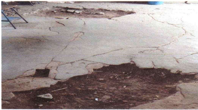
Sustitución de piso de torta de concreto
