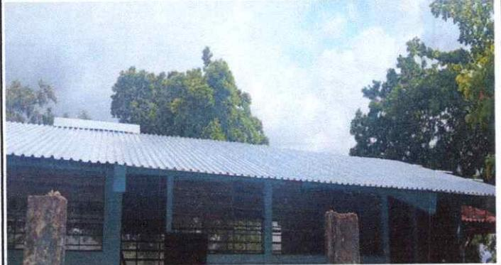
SUSTITUCIÓN DE LAMINA CALIBRE 26
