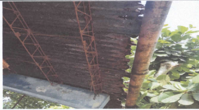
SUSTITUCIÓN DE LAMINA CALIBRE 26
