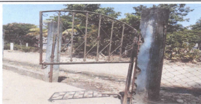
SUSTITUCIÓN DE PORTÓN DE METAL
