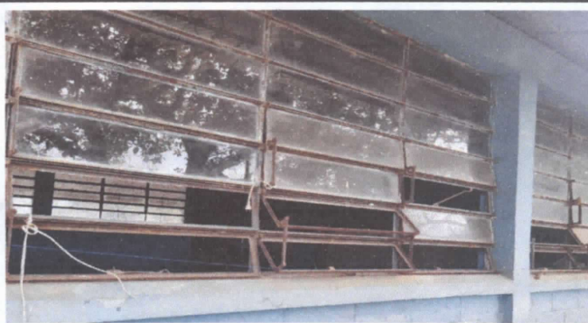
Fabricación e instalación de ventana-balcon de metal
