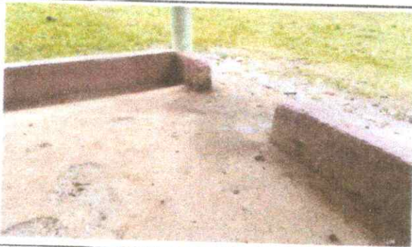
Foto 3: Sustrucción de piso de cemento líquido
