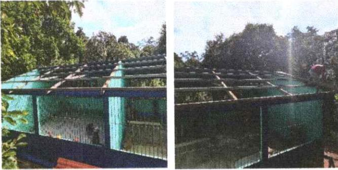
Ejecución del cambio de las láminas por láminas troqueladas.
