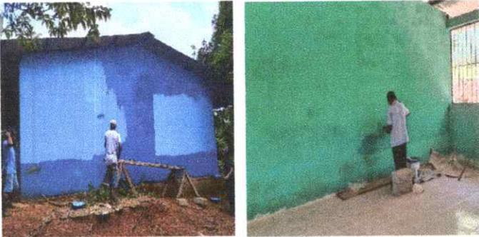
Aplicación de pintura en muros exteriores e interiores.
