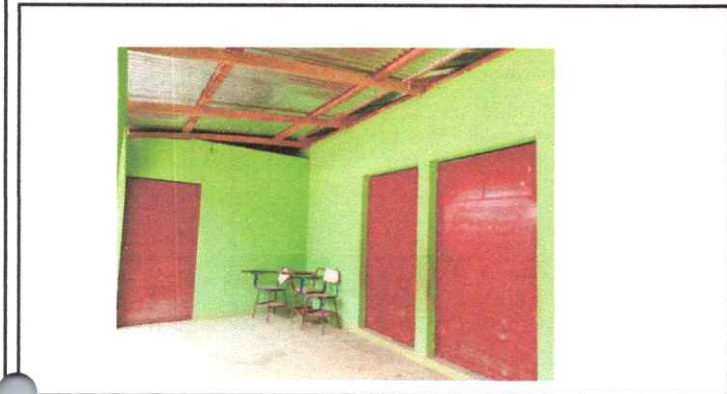
fotografia 1 remozamiento de puerta
