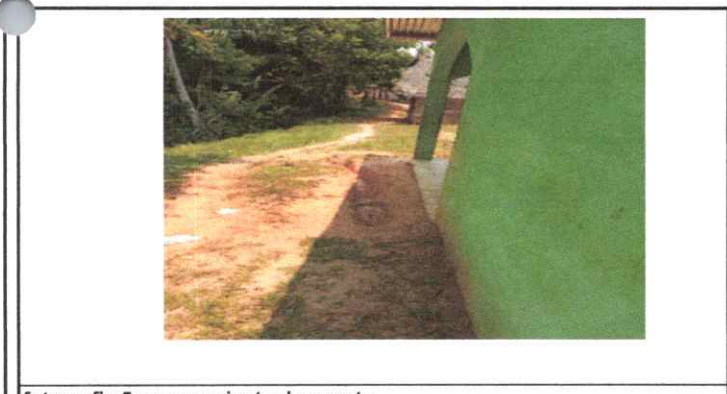
fotografia 5 remozamiento de cuneta
