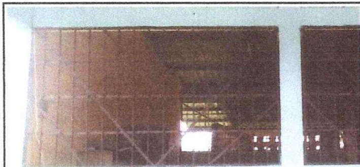
FOTO 3: Mantenimiento a estructura de soporte de metal
