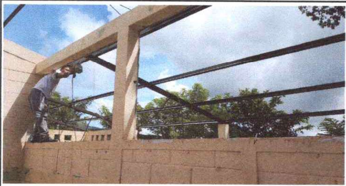
FOTO 3: Mantenimiento a estructura de soporte de metal
