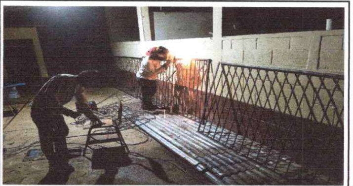
FOTO 4: Sustitución de estructura de metal de ventana
