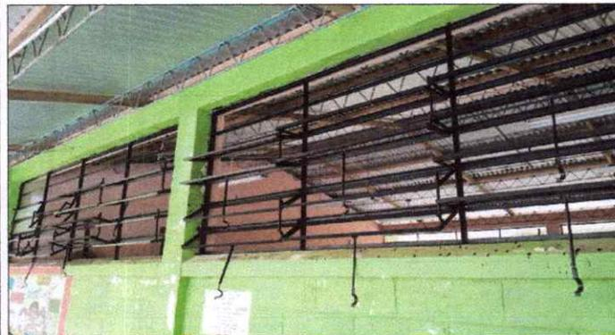
Foto 3: Montaje eficiente de las ventanas de vidrio y metal.
