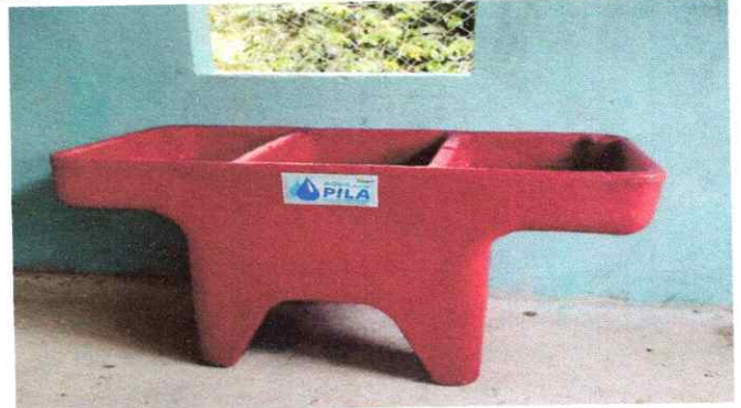
Foto 2: sustitución de pila plástica de dos lavaderos
