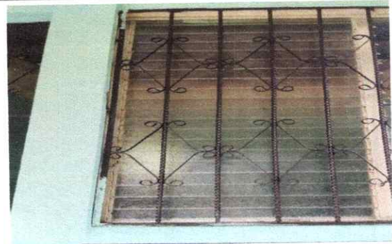
Piso 6: Sustitución de vidrios
