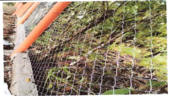
Foto 4: Reparación de tubo hg y malla galvanizada
