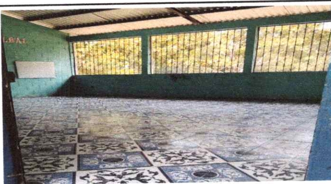
Foto 5: Sustitución de piso cerámico
