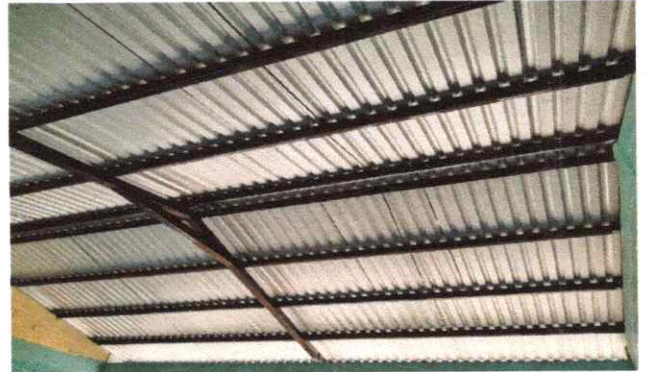
Foto 8: los soportes de metal fueron pintadas con pintura anticorrosiva para luego colocar las láminas
