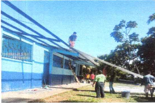
Foto 1 : de forma coordinada se sustituyeron las láminas
