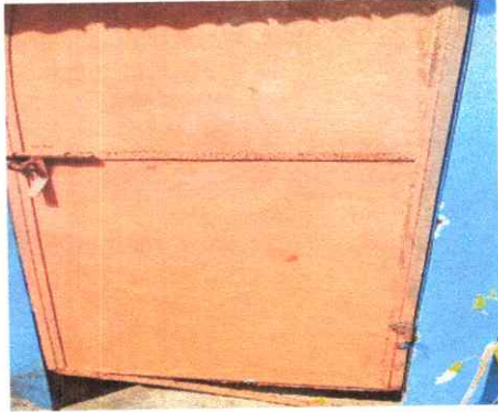
Foto 7: Mantenimiento a puertas de metal
