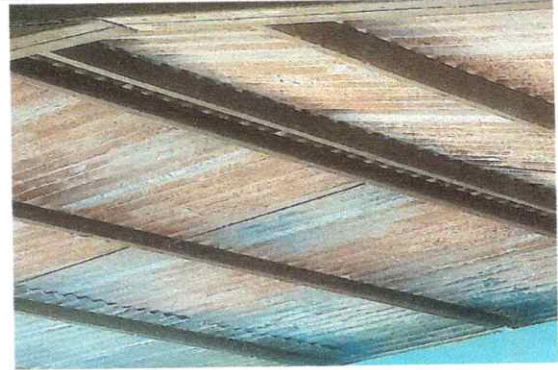
Foto 8: mantenimiento a estructura de soporte de metal
