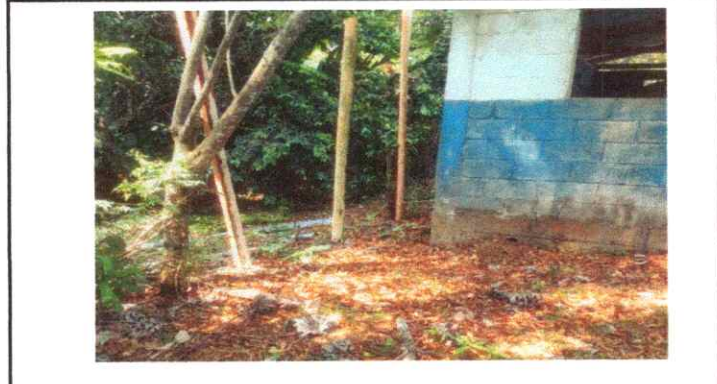
Foto 4: Reparación de tubo hg y malla galvanizada
