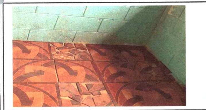
Foto 5: Sustitución de piso cerámico
