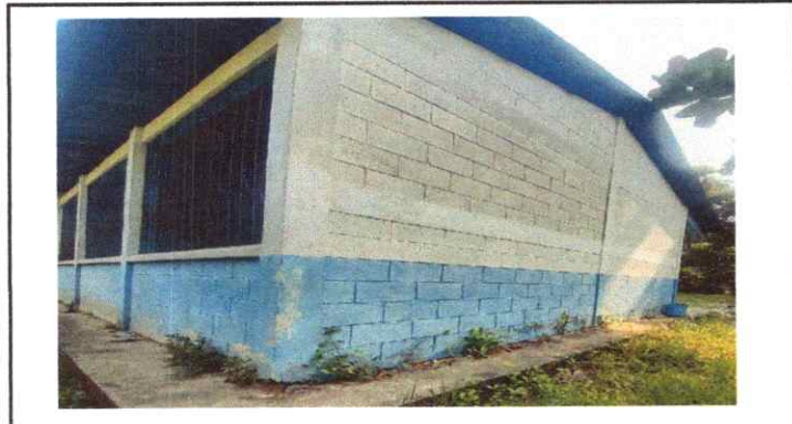
Foto 3: Pintura en exteriores e interiores
