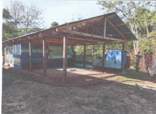
Relleno de Piso de cemento.
