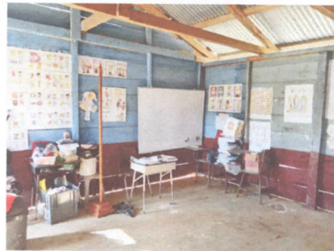
Reparación de pared, sustitución de tablas a block
