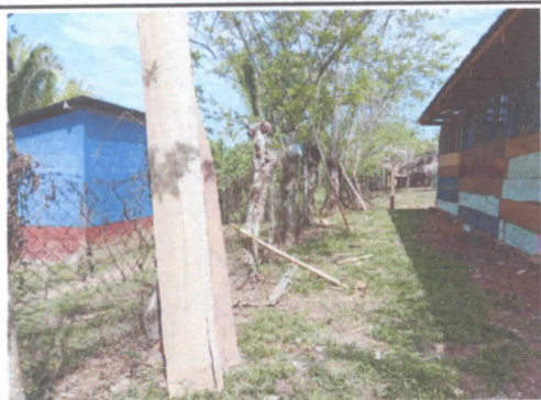
Levantamiento de muro perimetral con malla y postes de cemento
