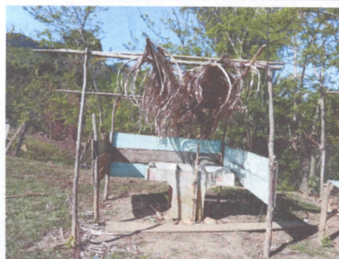
Ampliación y techado de pila escolar
