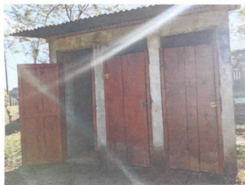
Reparación de Santuario de pozo ciego a sanitarios lavables
