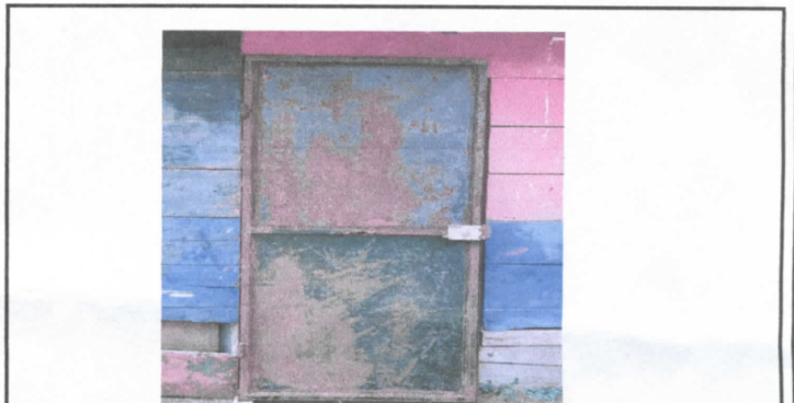
fotografía 4: Sustitución de puerta
