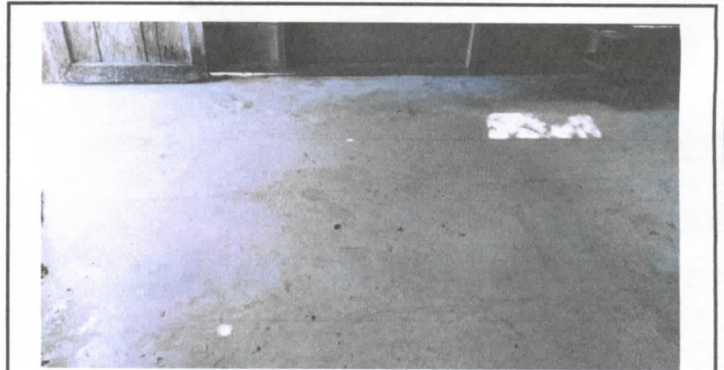
fotografía 2: Relleno de piso
