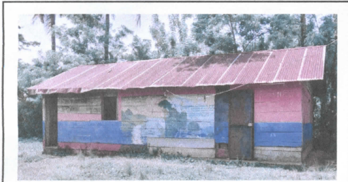
fotografía 1: Sustitución de lámina, por lámina troquelada aluzinc
