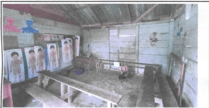
fotografía 3: Sustitución de madera a block
