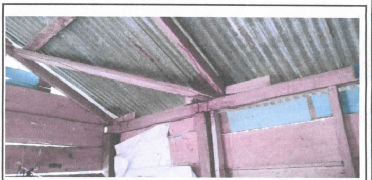
fotografía 6: Sustitución de estructura de soporte de madera, por metal
