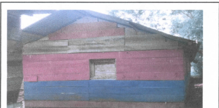
fotografía 5: Sustitución de ventanas
