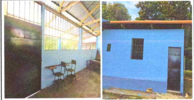
Foto 2: Se colocaron Balcones y Puertas de la Dirección.
