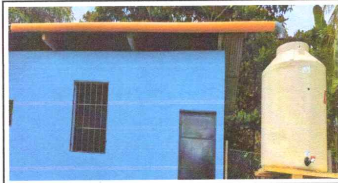
Foto 4: Colocacion de canal de agua para el tanque.
