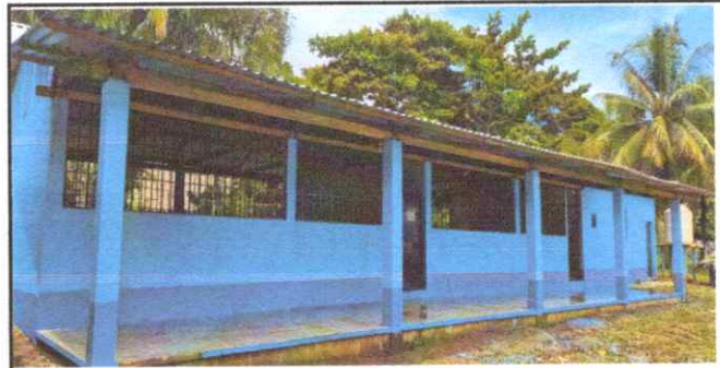
Foto 6: Trabajo Finalizado de la Escuela.
