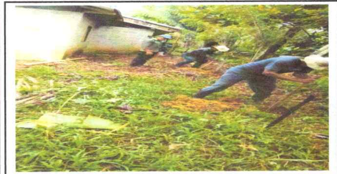
Foto1: Preparando el Area para la colocacion de poste.
