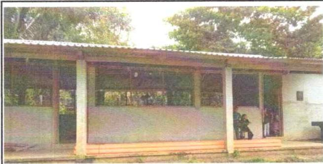
Foto1: Falta de pintura y canal de agua.
