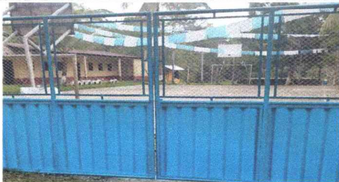
MANTENIMIENTO A PORTONES DE METAL
