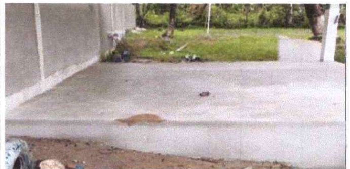
SUSTITUCIÓN DE PISO DE TORTA DE CONCRETO DEL ESCENARIO
