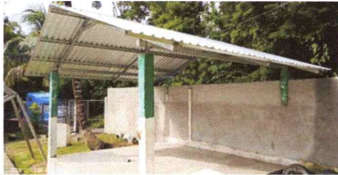
SUSTITUCIÓN DE LÁMINA, POR LÁMINA TROQUELADA ALUZINC CALIBRE 26 DEL ESCENARIO
