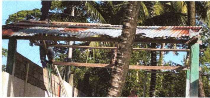
SUSTITUCIÓN DE LÁMINA, POR LÁMINA TROQUELADA ALUZINC CALIBRE 26 DEL ESCENARIO
