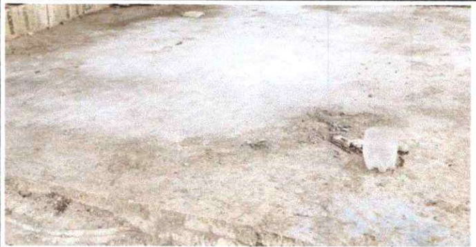
SUSTITUCIÓN DE PISO DE TORTA DE CONCRETO DEL ESCENARIO
