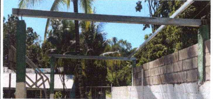
MANTENIMIENTO A ESTRUCTURA DE SOPORTE DE METAL DEL ESCENARIO
