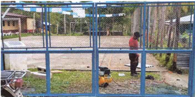
MANTENIMIENTO A PORTONES DE METAL
